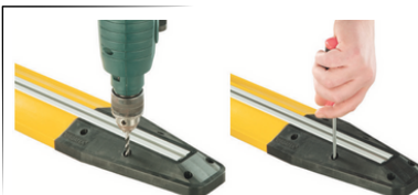
Fissare definitivamente i terminali utilizzando viti e tasselli
